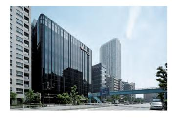
新宿5丁目靖国通り沿いの厚生年金会館跡地に、既存データセンターに隣接して、本社機能と分散する関連会社を、移転・統合したプロジェクト。外装は、ガラスとスリット壁が交互に連なるカーテンウォールで構成した。細かい分節が陰影を纏いながらガラスを浮かび上がらせる漆黒のファサードが、カメラのように都市を写影し、靖国通りに建つ新本社としての存在感を呈している。複層ガラスは、熱線吸収ガラス(外側)とLow-eガラス(内側)にて外皮熱取得率を大幅に低減し、スリット壁にはパネル目地から室内に給気する機構を仕組んだ。化学強化ガラスにて強度と精度を備えたコーナーの曲面は、南東面の連続性と建築全体の親和性をもたらしている。
