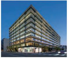
博多駅近くに位置する高規格テナントオフィスビル。事業企画から設計・施工・建物管理まで全てを鹿島が手掛け、「繋がり」をプロジェクトのコンセプトとした。その象徴として建物全周に廻らせた白い庇は、方位や隣接環境に応じて大きさの異なる開口部を持つファサードを統合している。近隣の公園をつなぐネットワークとして建物周囲に緑豊かな歩行者空間を、屋上には憩いの場となる庭園や、施設内での資源循環を生み出す菜園を設けた。また、貸室内専用階段、高セキュリティエリア、社員食堂や保育所の設置、高密度・高負荷への対応など、テナントの要望に対しても、柔軟な対応ができる構造、設備の骨格を備えている。
