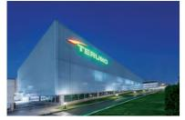
急拡大する医療用カテーテル製品需要に応える3期 棟工場プロジェクト。生産エリアは3極GMP、PICs、中 国GMPに対応するアジア地域の拠点確立を目指し、2 層の生産エリアとEOG滅菌エリアの明快なゾーニング と、自動ラック倉庫による高効率の物流動線と従業員 動線により計画されている。生産設備に対しては生産 電源AVR、自家発フルバックアップ、モジュールチラーな ど製造品目に最適かつ信頼度の高いシステムを導入し た。施設全体の顔となる管理棟の外装は、企業イメージ を表象する端正で純白な顔づくりをコンセプトとし、眺望・ 温熱環境・自然採光を考慮した優れた外皮性能を持っ た、周辺環境にも調和するシンプルで印象的な外観を 実現した。
