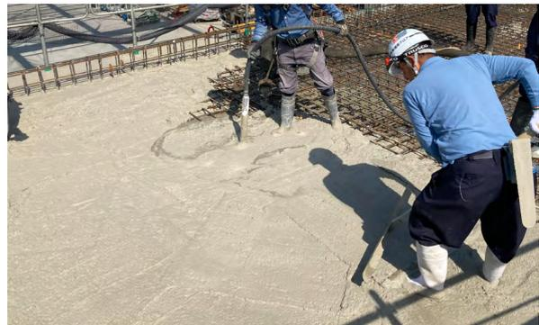
Photo 1 デッキスラブ床の打設 (Casting of Deck Slab Floor)
