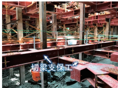
開削工事における切梁支保工 Struts in Excavation Works
