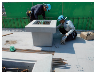
Photo 2 施工状況 (Construction Status)
