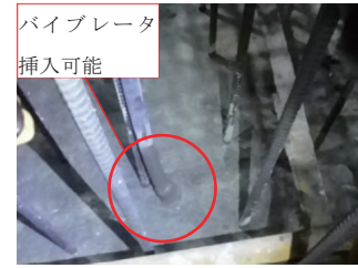
Photo 5 19 時間後の表面の状態 (Condition of Concrete after 19 hr)
