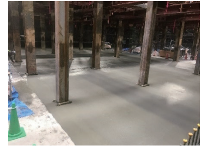
Photo 6 構築された底版 (Constructed Base Plate)
