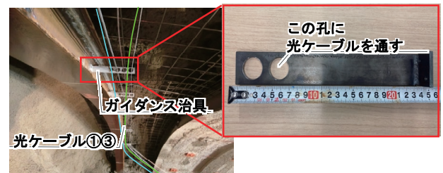
Photo 2 吹付けコンクリートへの敷設 (Optical Fiber Cable Placed in Shotcrete)
