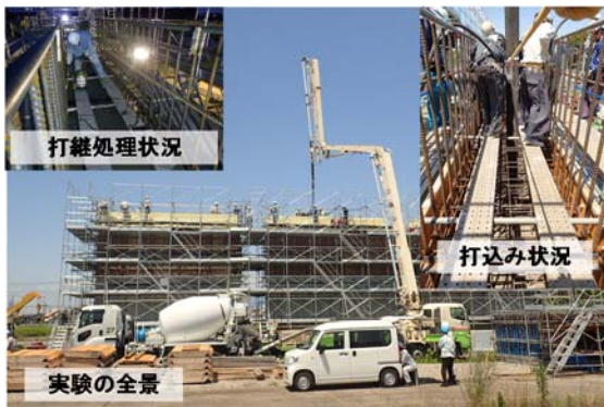
Photo 2 コンクリートの打込み状況 (Concrete Placement Situation)
