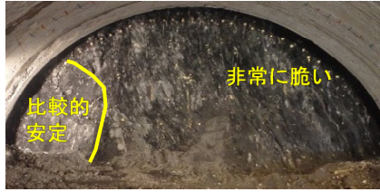
破碎帯部で左側から比較的安定してきている (5シフト施工切羽から1m前方の切羽)
