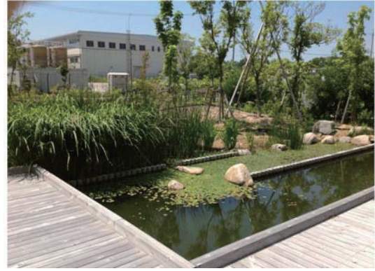
Photo 4 竣工後3年目のビオトープ状況 (2014年7月) (Photo of the Biotope 3 Years after the Completion)
