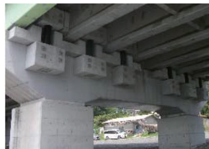
Photo 5 ダンパの設置状況 (Installation of Dampers)
