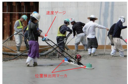
Photo 3 位置検出用マーク及び速度ゲージの設置状況 (Installation Situation of Markers and Speedometer for the System)
