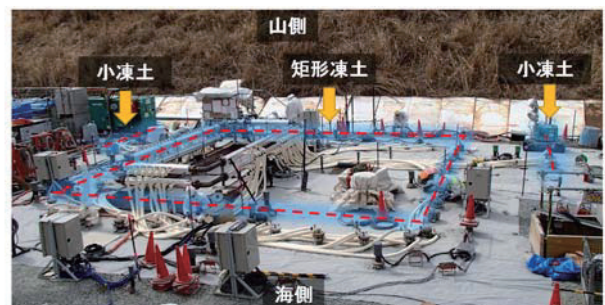
Photo 1 試験ヤード状況 (View of the Test Yard)
