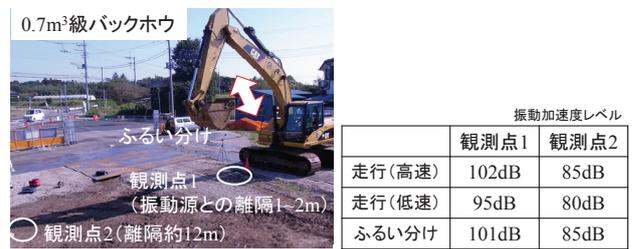
Photo 2 作業状況と計測結果
