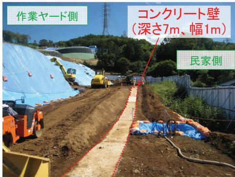
Photo 3 コンクリート遮振壁の設置状況
