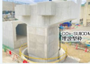
高速道路橋脚※埋設型枠に適用
