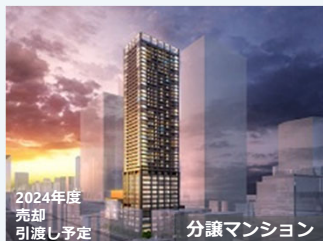
WORLD TOWER RESIDENCE (東京都)
